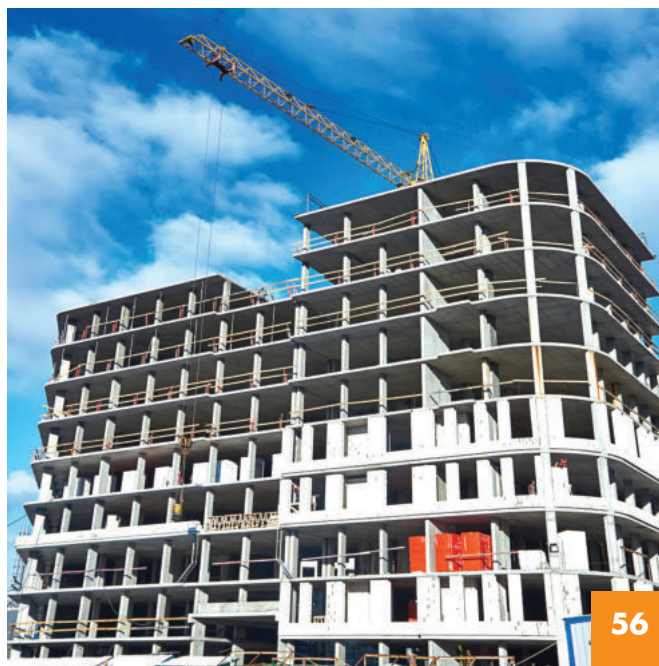
Мурування взимку на прикладі будівництва ЖК «Республіка», м. Київ 2018 р.
